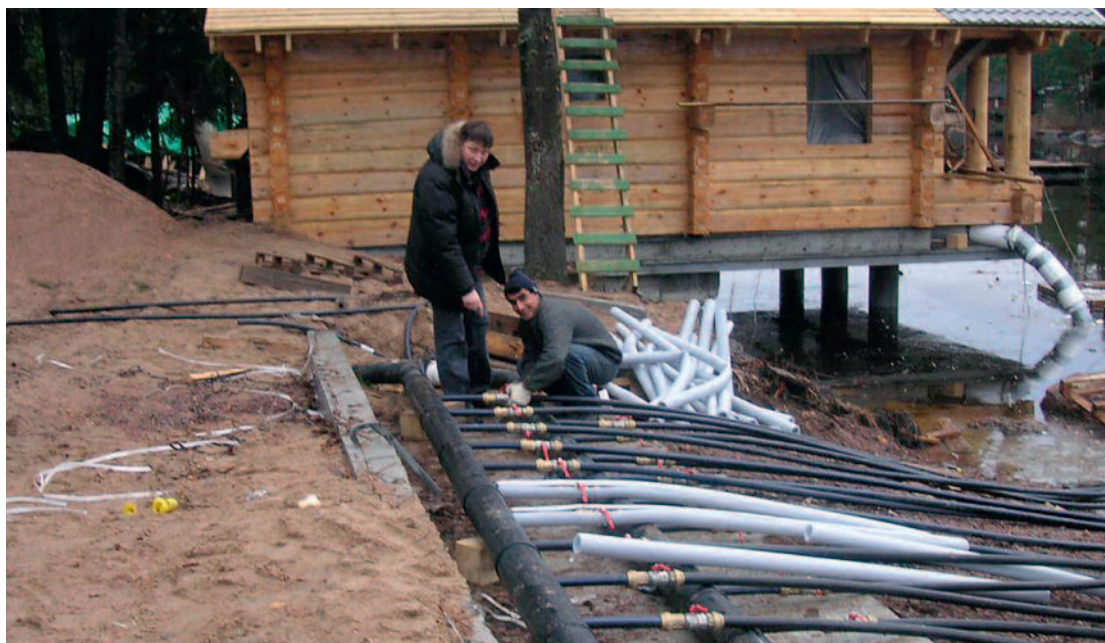
Рис. 2. Подсоединение водного контура теплового насоса
