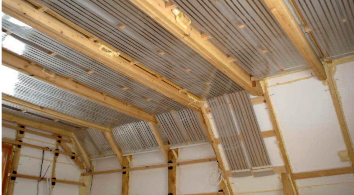
Рис. 4. Установка пленочно-лучистых электронагревателей
