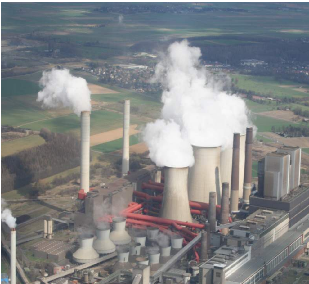
Рис 3 Самые экономичные ГРЭС вынуждены выбрасывать через градирни в окружающую среду до 60% энергии сжигаемого топлива.
