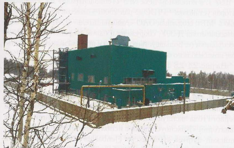
Рис. 2.1. ГТУ-ТЭЦ «Шигили», 4 МВт (Мечетлинский район Республики Башкортостан, энергоустановка расположена в главном корпусе).
