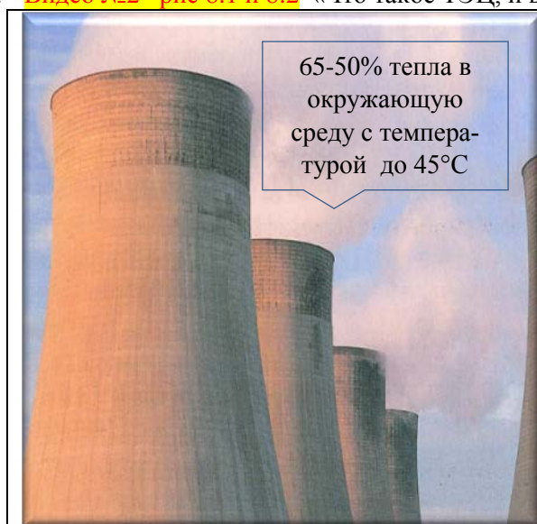
Рис 1. Оработанное тепло ГРЭС в количестве 60÷65% от поступающей энергии топлива сбрасывается в воздух с температурой до 45°C
